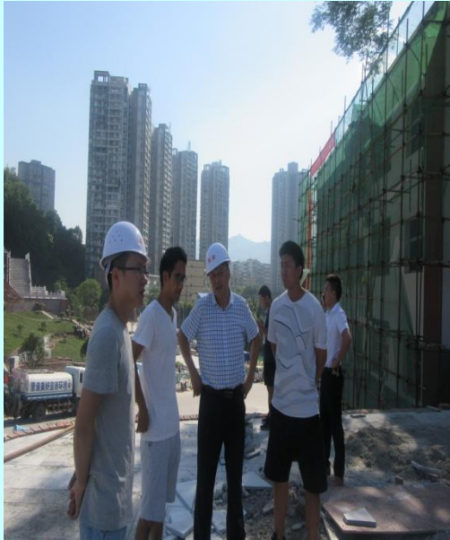
总经理检查施工现场
