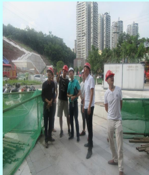
总工程师及质监站检查施工现场
